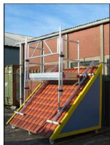
Dubbele leuningschoor plaatsen. De set inclusief kantplankset
